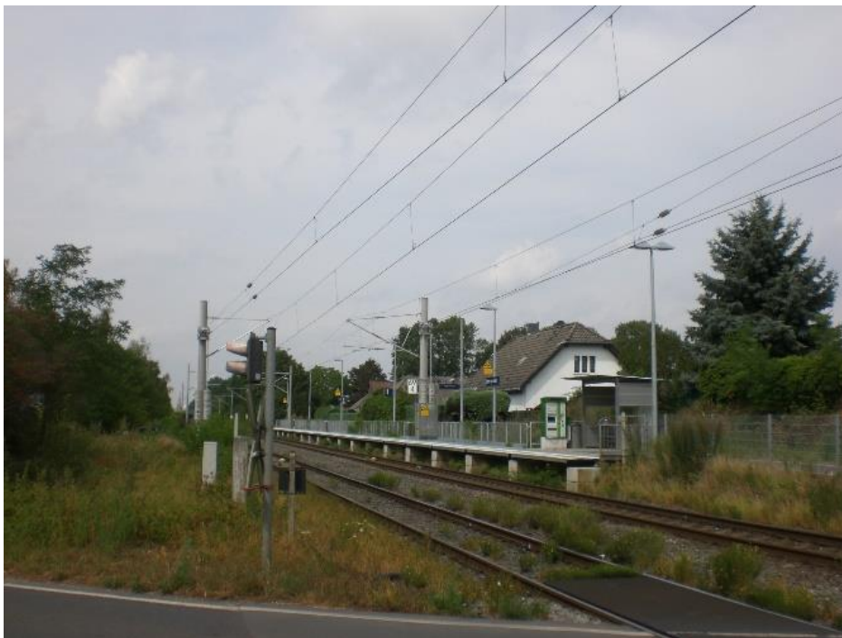
Foto 000: SPNV-Station Emmerich-Elten im Zuge des Ausbau RRX (Quelle: VRR AöR)
